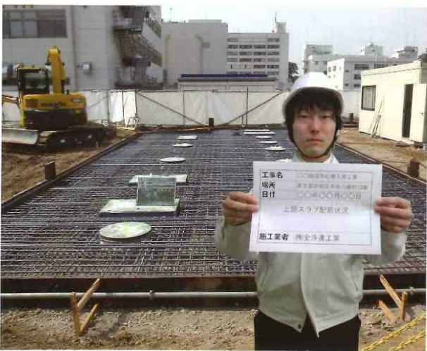
※実際の写真は、工事現場と所定の看板を持った浄化槽設備士を共に撮影し、設備士は顔が見えるようにすること。
